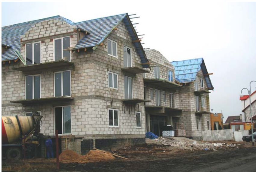
Fot. 3. Budowa nowego obiektu wypoczynkowego w gminie Rewal (fot. M. Bednarek) New recreational facility under construction in Rewal commune
