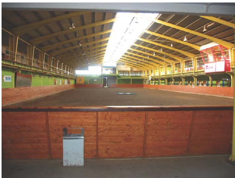
Fot. 7. Kryta ujeżdżalnia w Centrum Hippiki w Jaszkanie (fot. A. Kołodziejczak) Indoor riding arena in the Center for Horse Riding in Jaszkanie
