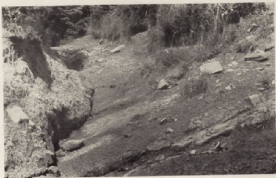
Fot. 11. Rów rozpadlinowy w górnej części osuwiska na zboczu doliny Kościelca
