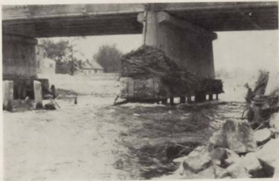
Fot. 10. Podmyty nowy most zbudowany po powodzi w 1958 r. Obnażone fundamenty mostu wskazują głębokość wcięcia koryta po powodzi w 1960 r. (Żywiec)
