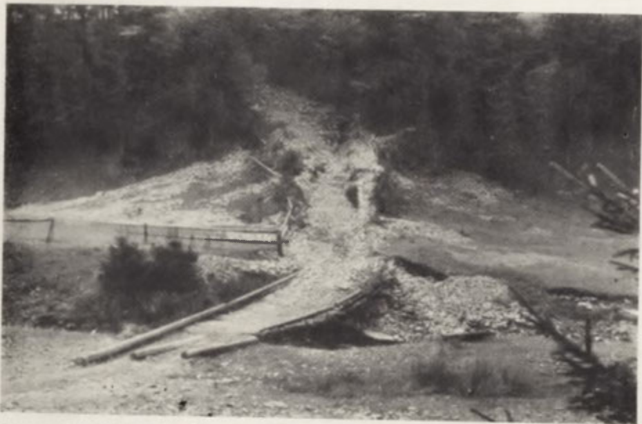
Fot. 5. Akumulacja żwirów po powodzi w 1958 r. u wylotu wciosu drogowego (górny Szczyrk)
