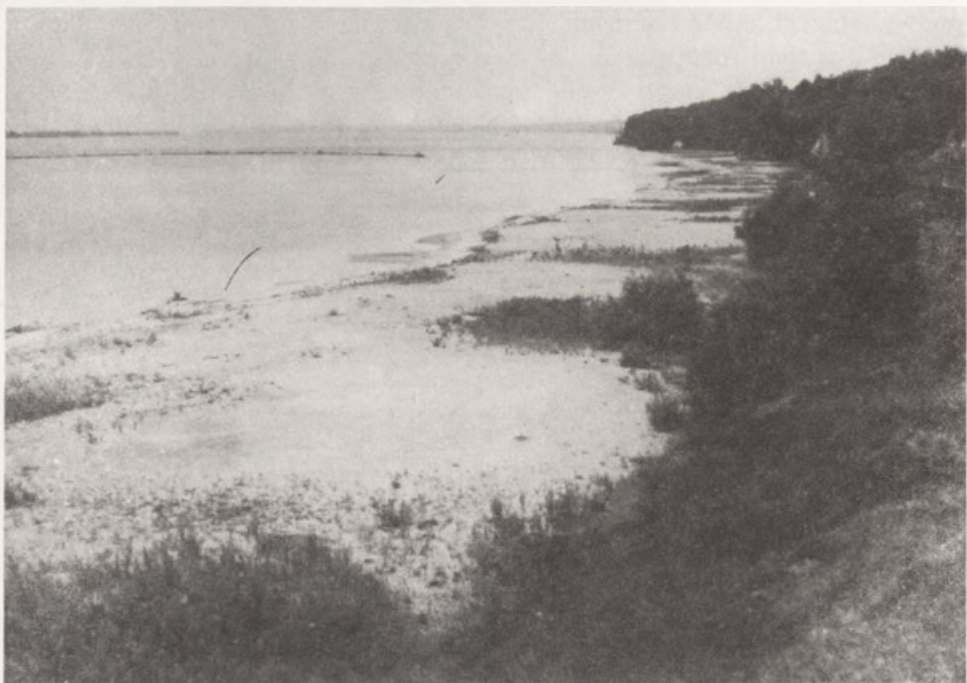
Fot. 9. Sztuczna terasa wzdłuż byłego abrazyjnego, osuwiskowego brzegu w Murzynowie, narefultowana w latach 1982–1983 (30.05.1985)
