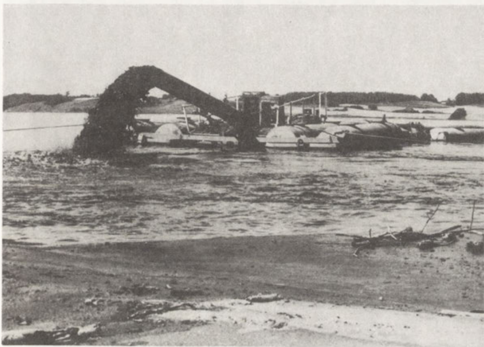
Fot. 8. Bagrowanie na zbiorniku zalanych kęp śródkorytowych Wisły metodą refulowania (zasysania i tłoczenia rurami osadu wraz z wodą) (Fot. M. Grześ, lato 1985)
