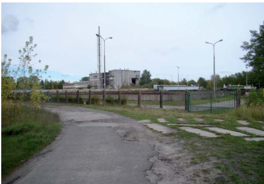
Fot. 4. Oczyszczalnia ścieków na terenie zagrożonym powodzią w Tomaszowie Mazowieckim A wastewater treatment plant within the flood hazard area of Tomaszów Mazowiecki
