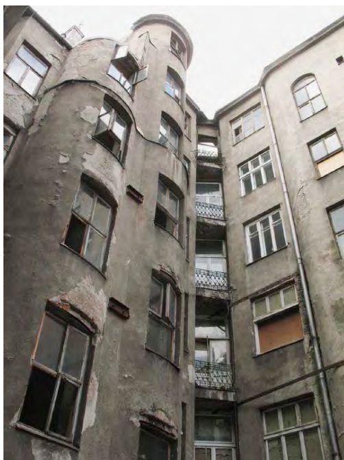
Fot. 5. Widok na ścianę podwórza warszawskiego. Pośrodku widać wcięcie narożnika, w którym zaprojektowano okna pokojów berlińskich (z balkonami). Po lewej obły kształt oficynowej klatki schodowej stanowiącej integralną część zabudowy. Ulica Pańska, Wola, fot. A. Łupienko.
