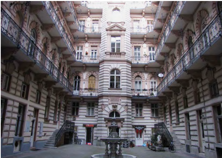
Fot. 2. Podwórze pałacowej kamienicy budapeszteńskiej. Bogata oprawa architektoniczna (obramienia okien, boniowanie ścian, ozdobne żeliwne balustrady). Na wprost wysunięta przed lico ściany podwórza klatka schodowa. Szent István körút, Lipótváros, fot. A. Łupienko.
