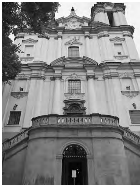
157. Fasada kościoła św. Michała Archanioła i św. Stanisława Biskupa z wejściem do Krypty Zasłużonych, widok obecny.
