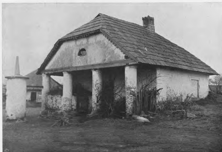
192. MNISZÓW, DOMEK Z PODCIEMIEM PRZY WJEŹDZIE DO FOLWARKU, Z POCZĄTKU XIX W.
