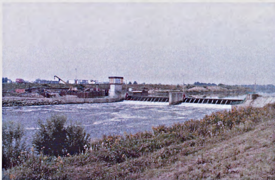
Rys. 3.12. Stopień Smolice. Smolice weir.
