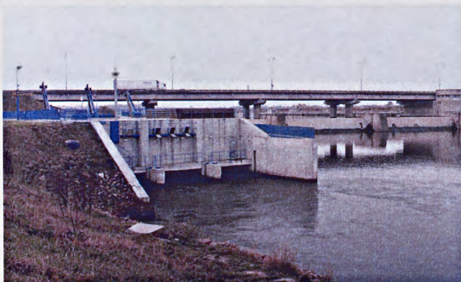
Rys. 3.14. Stopień Kościuszko. Z prawej wejście do śluzy, z lewej elektrownia wodna. Kościuszko weir, on right entrance into sluice, on the left bank is small hydro-electric power station.
