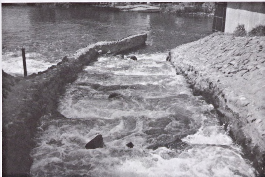
Ryc. 11. Przeplawka ryglowa, będąca kombinacją bystrotoku i przeplawki komorowej (fot. W. Wiśniewski).
