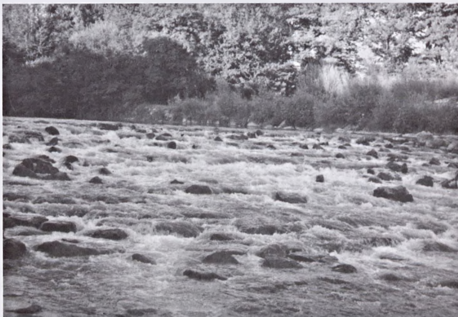
Ryc. 10. Przeplawka w formie bystrotoku posadowionego na całej szerokości rzeki i zastępującego próg piętrzący (fot. W. Wiśniewski).
