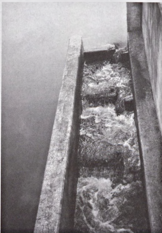
Ryc. 8. Przeplawka typu szczelinowego (fot. PZW).
