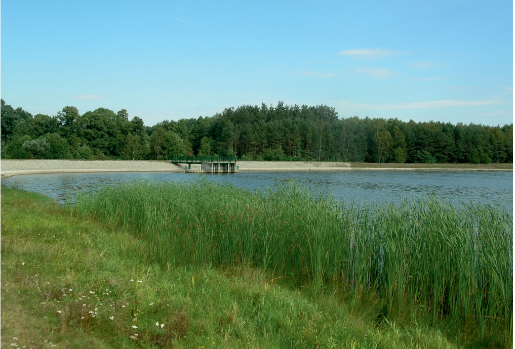
Ryc. 12. Widok Zbiornika Próba (fot. A. Pocięcha)
