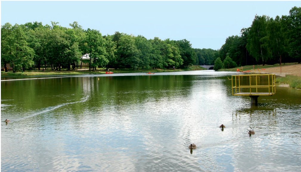
Ryc. 52. Widok miejskiego zbiornika zaporowego – Zbiorniki Arturówek (Łódź–Łagiewniki) (fot. A. Pociecha) Fig. 52. View of the Arturówek Dam Reservoirs (Łódź–Łagiewniki) (photo by A. Pociecha)
