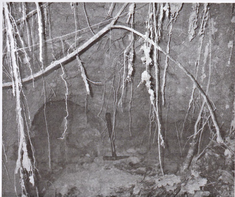
Ryc. 8. Kanaly podziemne w zachodniej części środkowego otworu (zapadliska) (obiekt C) Tunelu w Bugaju – stan w marcu 2002 r. – Underground pipes in the western part of the middle (collapsed) entrance (object C) of Tunel w Bugaju cave – state in March 2002
