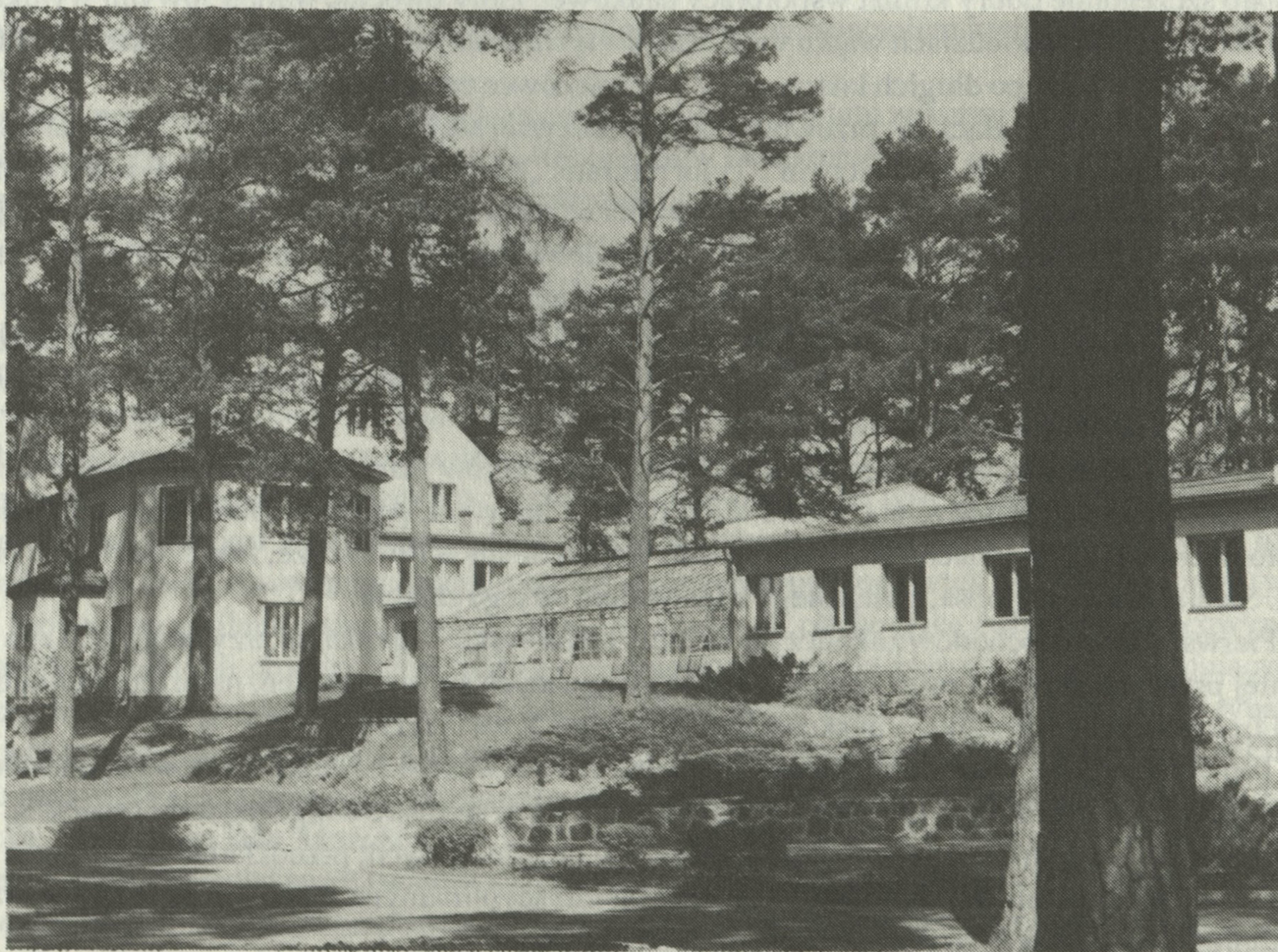
Rys. 1. Zabudowania Stacji Hydrobiologicznej w Mikołajkach (fot. L. Kufel)
