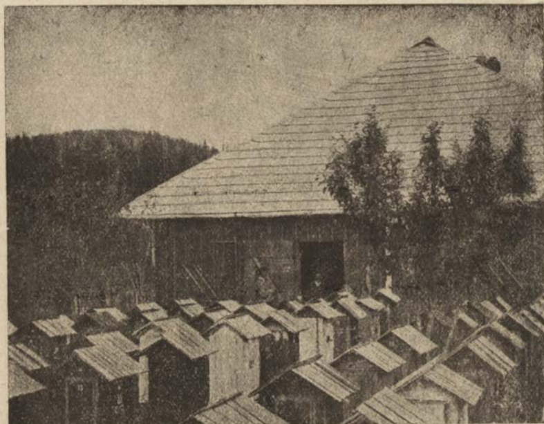
Ryc. 56. Pasieka p. Jana Marcinkowa, nadleśniczego w Sołotwinie Mizuńskiej 650 m. nad poziom morza, w otoczeniu karpackich szczytów 1200—1490 m. wys. nad poziom morza.
